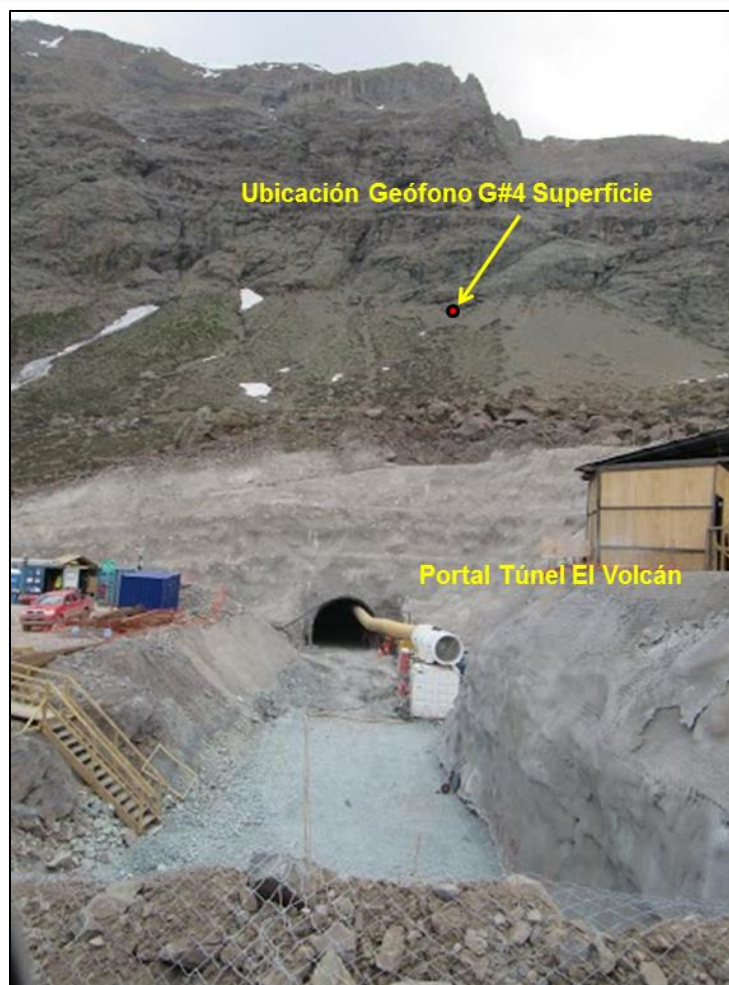
FIGURA 8. UBICACIÓN GEÓFONO G#4 SUPERFICIE
